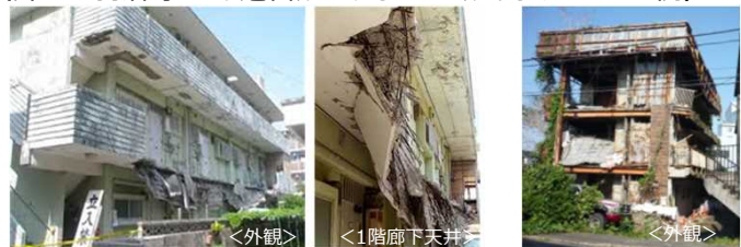
2階の廊下部分が崩落した事例
